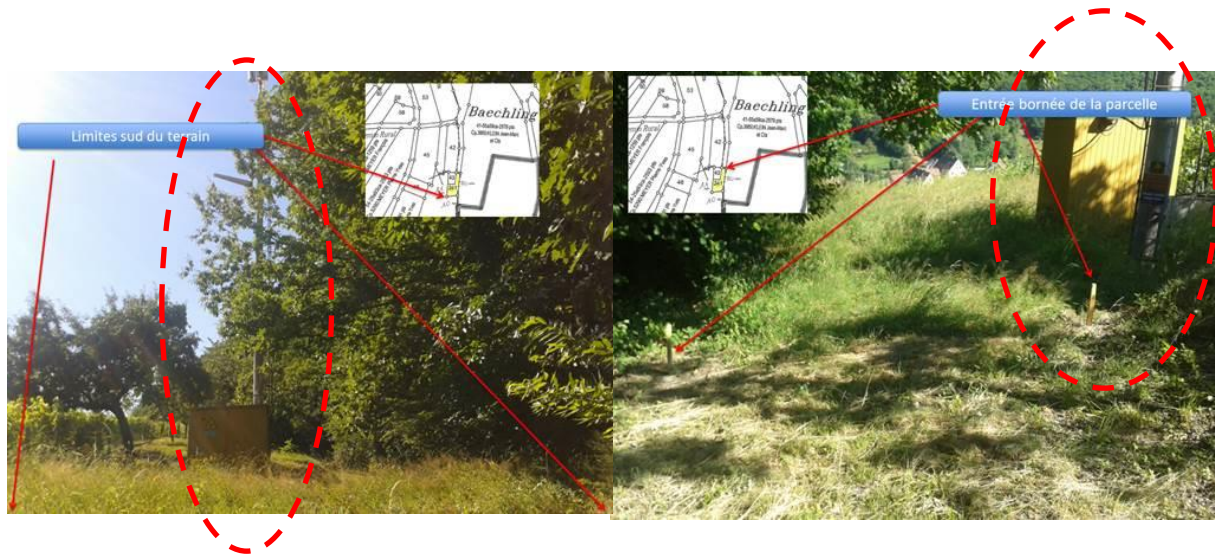
Figure 13 : Photo du mât déjà présent sur le site
