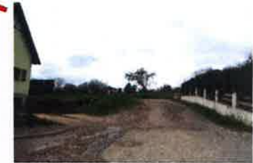
Vue de l'amorce de voie rue de l'Eglise
