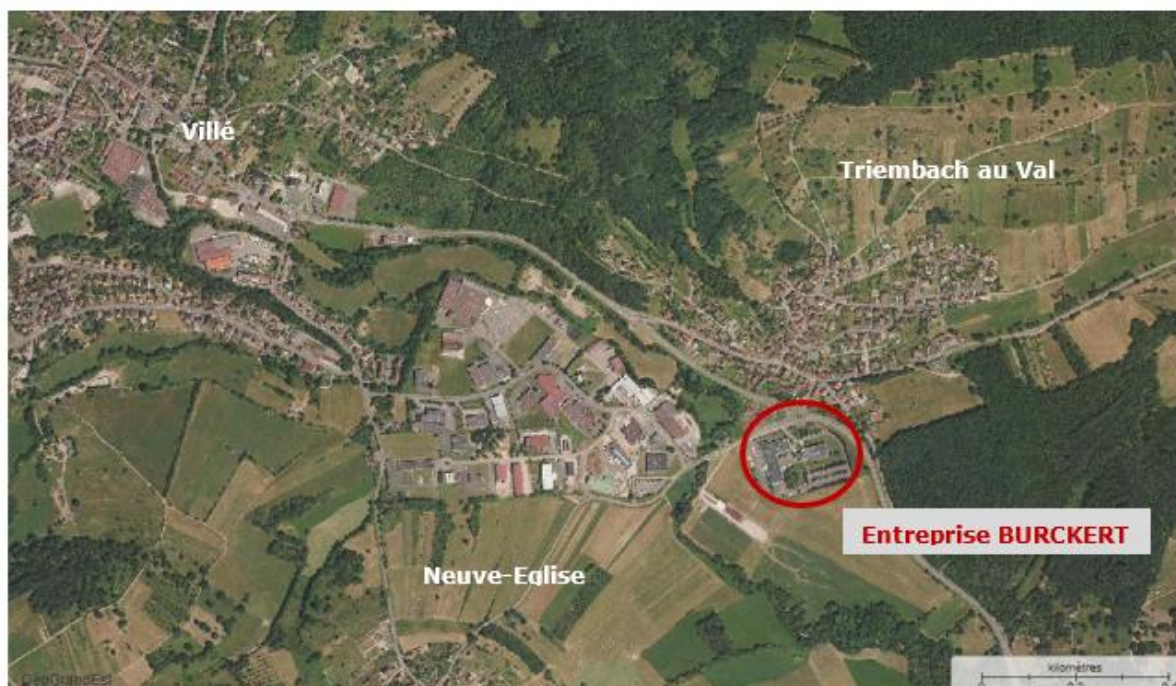
Plan de situation de l'entreprise Bürkert à Triembach au Val et Saint-Maurice
