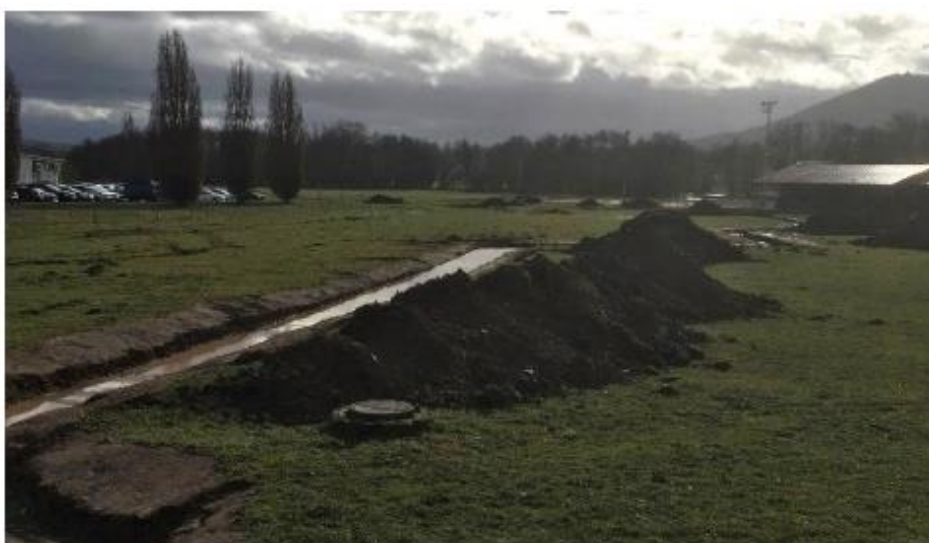
Travaux sur le site en janvier 2021 : la tranchée creusée dans l'axe de la parcelle crée une pièce d'eau temporaire qui pourrait attirer les amphibiens au printemps (Grenouille verte notamment).
